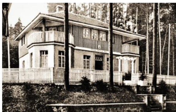
Das Spessarthaus wurde schon 1933 von den Nazis konfisziert
